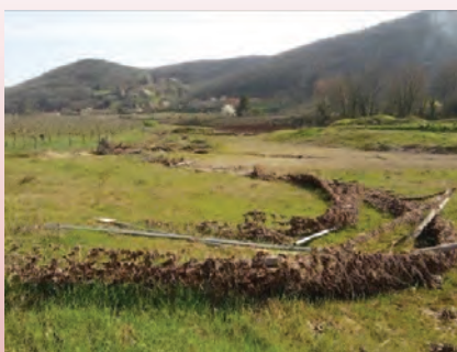
Clôture de limite d'emprise Pech rive gauche FSE n°30 04/03/21
