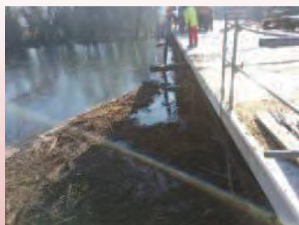
Estacade Pech rive droite
