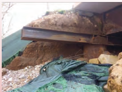
Bâche de protection Pech rive gauche
