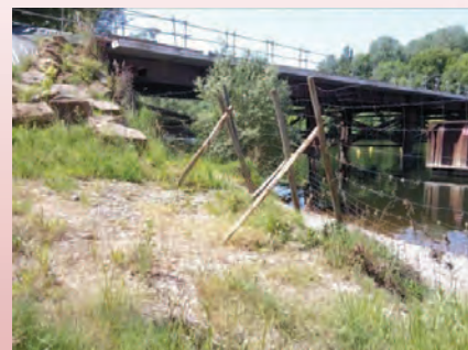
Clôture en limite d'emprise Fayrac rive droite
