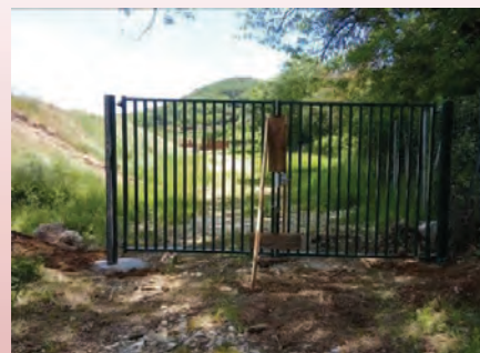
Portail d'accès au pont rail des Milandes FSE n°33 20/05/21
