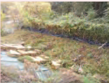
Fayrac rive gauche : estacade –zone sensible
