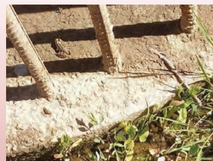
Grenouille verte coffrage de pile sur Fayrac rive droite
