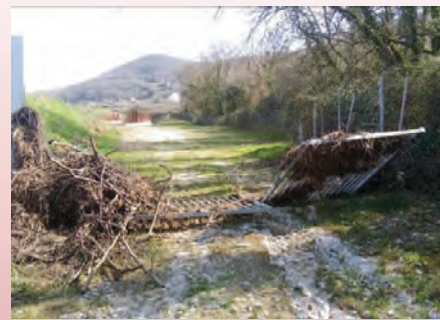
Portail accès pont rail Milandes FSE n°30 04/03/21
