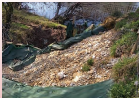
Bâche de protection Fayrac rive droite
