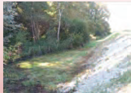
Fayrac rive gauche (pied de remblai / zone sensible)
