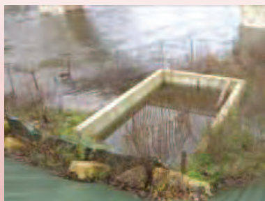
Emprise Fayrac rive droite inondée FSE n°28 17/12/20
