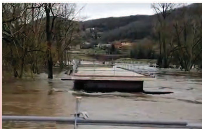
Emprise Pech rive gauche inondée 2 février 2021
