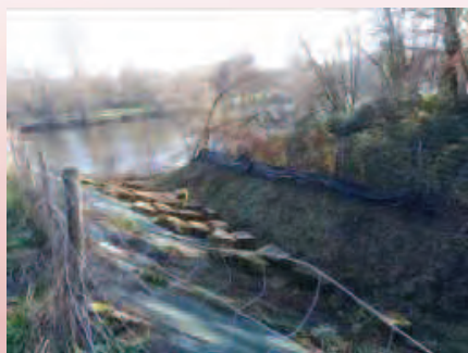
Débroussaillage Fayrac rive gauche
