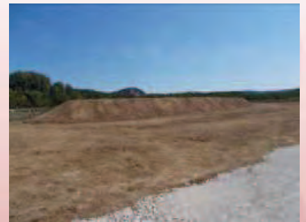
Stock de terre végétale suite au décapage emplacement du radier FCE n°2 Pra Milandes 04/09/18
